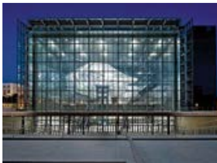
39 x 70 x 175 Meter: Die «Nuvola» im neuen Kongresszentrum von Rom.
