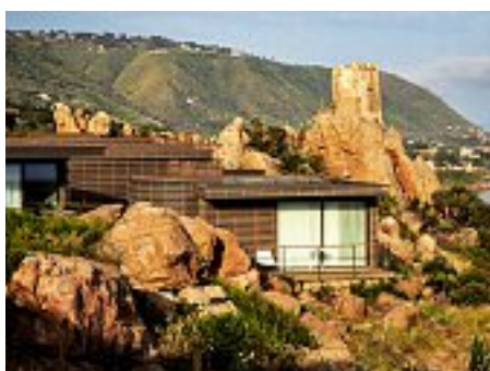
Hoch auf einem Felsvorsprung und anderthalb Stunden von Palermo entfernt, fügt sich der neue Club Med respektvoll in die Landschaft ein.
